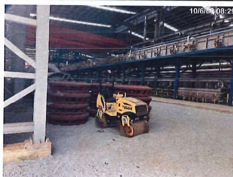
ภาพที่ 6 การจัดวางตำแหน่งอุปกรณ์ก่อสร้างที่อาจก่อให้เกิดเสียงดังในด้านที่ไม่ติดกับชุมชน
