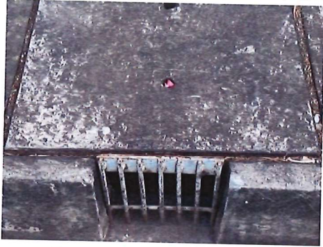
ภาพที่ 15 ตะแกรงดักขยะในรางระบายน้ำฝน
